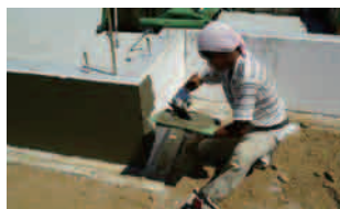
プライマー塗布・下地塗り
